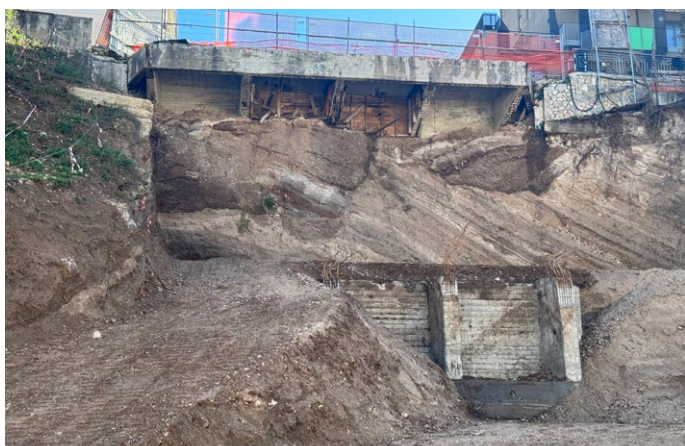
FIGURA 3. Il versante lato via Persichetti durante le demolizioni
