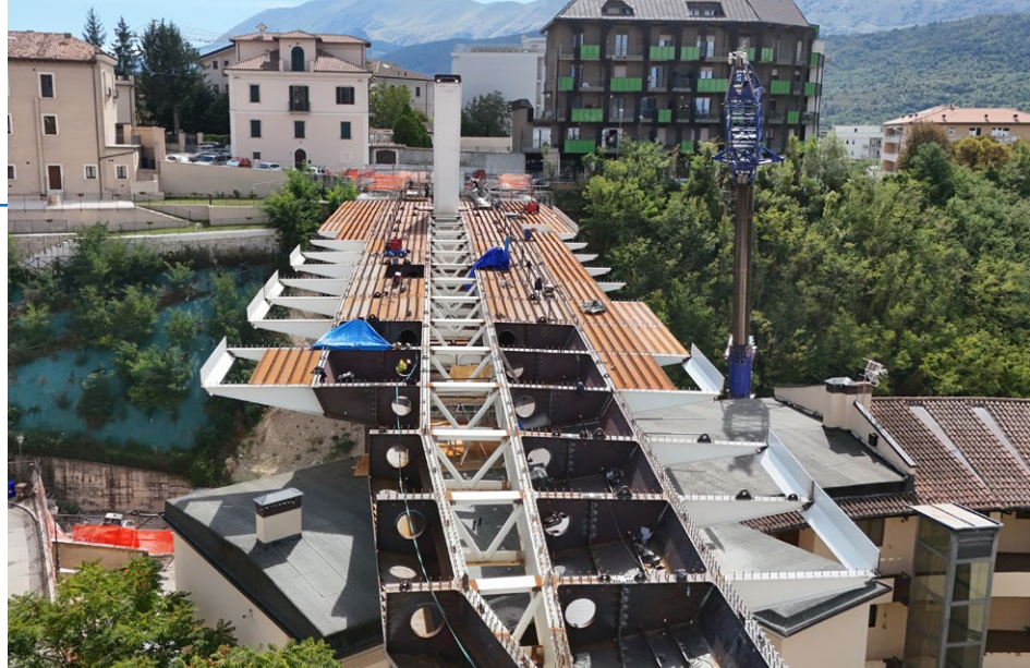
FIGURA 8. L'impalcato in costruzione del nuovo ponte del Belvedere
