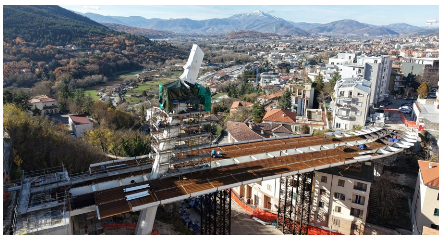
FIGURA 5. La geometria dell'impalcato
