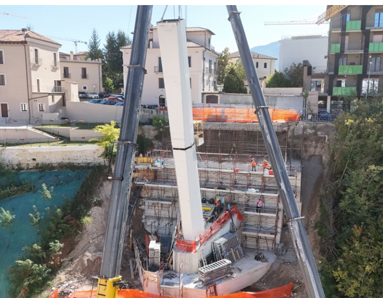
FIGURA 4. Il blocco scultoreo di ancoraggio lato via Persichetti
