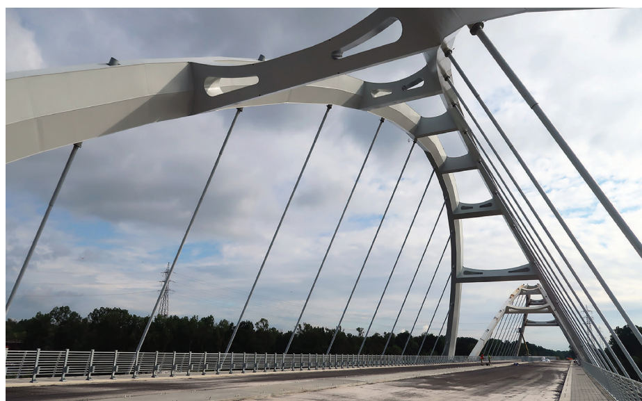
5. La sezione esagonale degli archi del nuovo ponte sul Ticino
