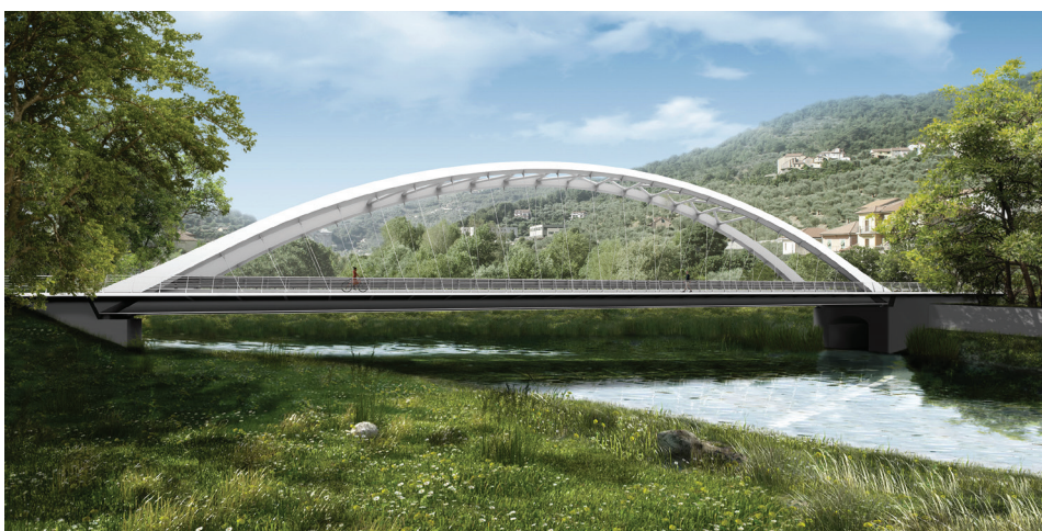
7. Il nuovo ponte sull'Impero a Borgo d'Oneglia
