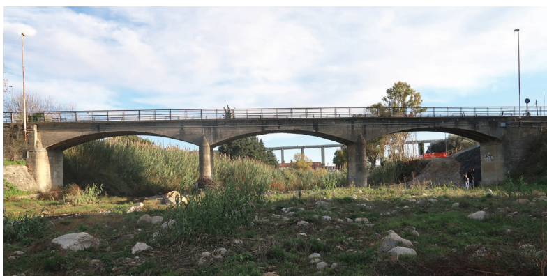
2. Il vecchio ponte sul Prino
