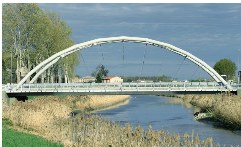
1. Il ponte ad arco sul canale di Burana a Bondeno
