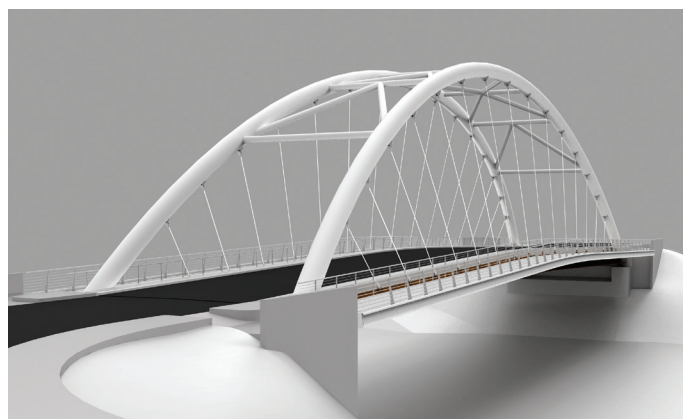
4. Il terzo e definitivo progetto del Prino: un ponte ad arco a spinta eliminata
