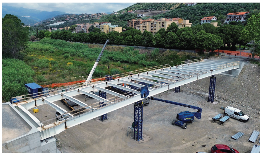
5. Il ponte sul Prino in costruzione
