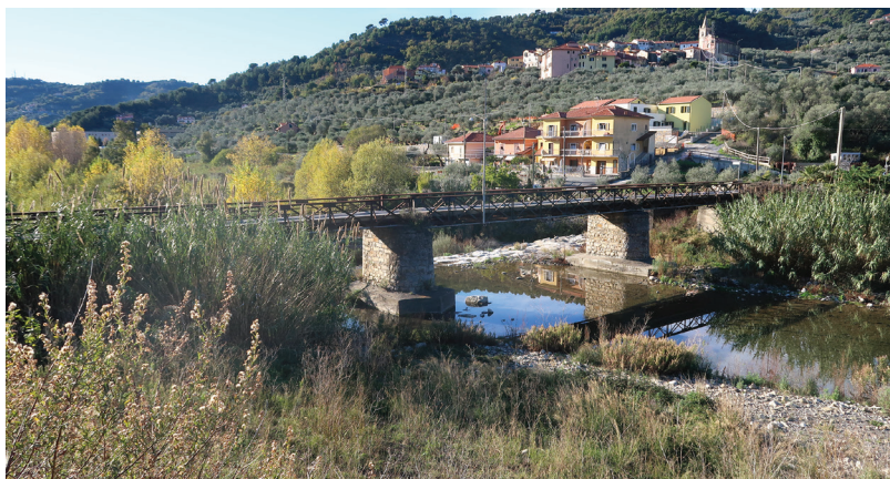
6. Il ponte esistente sull'Impero a Borgo d'Oneglia
