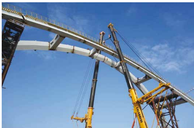
4. La costruzione degli archi
