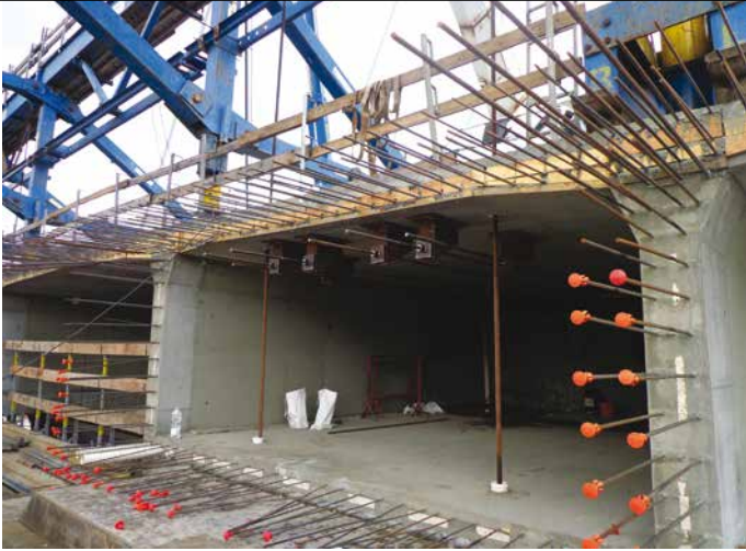
9. Il getto in avanzamento dell'impalcato e la precompressione provvisoria
