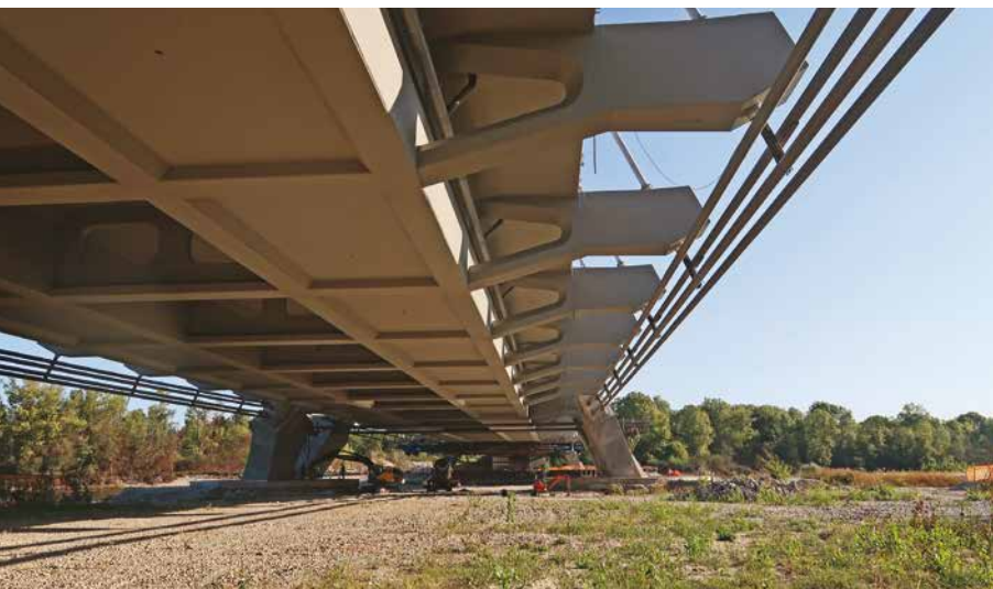
1. L'impalcato del ponte sul Ticino
