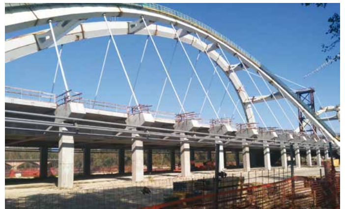
6. La costruzione dell'impalcato lato Vigevano con pile provvisorie
