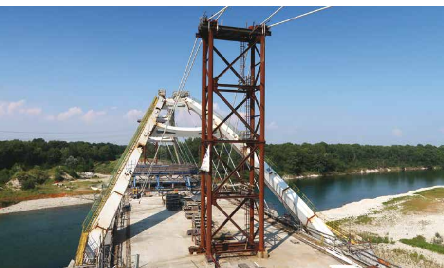
8. Il cantiere prima della ripresa dei lavori con la strallatura provvisoria in primo piano
