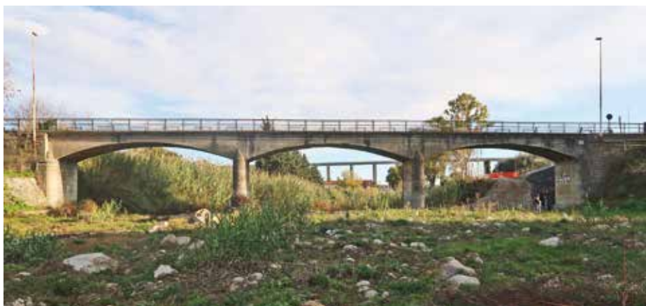
1. Il ponte sul Prino a Imperia (IM)
