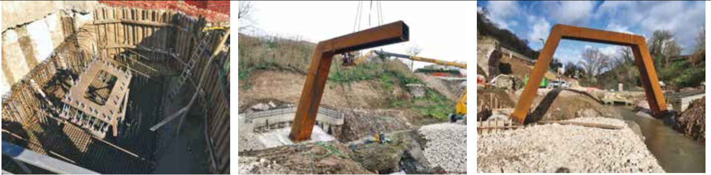
1A, 1B e 1C. Il montaggio del cavalletto "in avanzamento"
