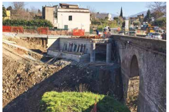
2A e 2B. La paratia di pali di 800 mm (2A) e la spalla (2B), lato Castel Madama
