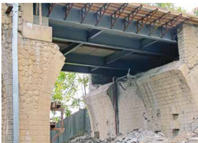
6. La nuova trave tampona
