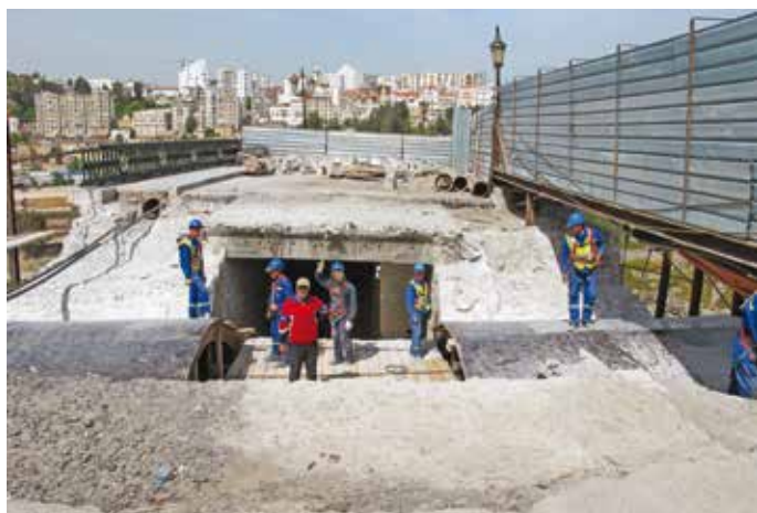
9. La demolizione della campata crollata
