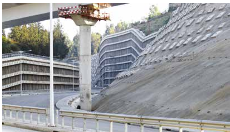
7. Interventi di consolidamento effettuati a salvaguardia del ponte Trans-Rhumel
