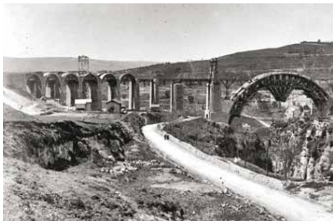
2. Una foto d'epoca con l'imponente centina dell'arcata principale
