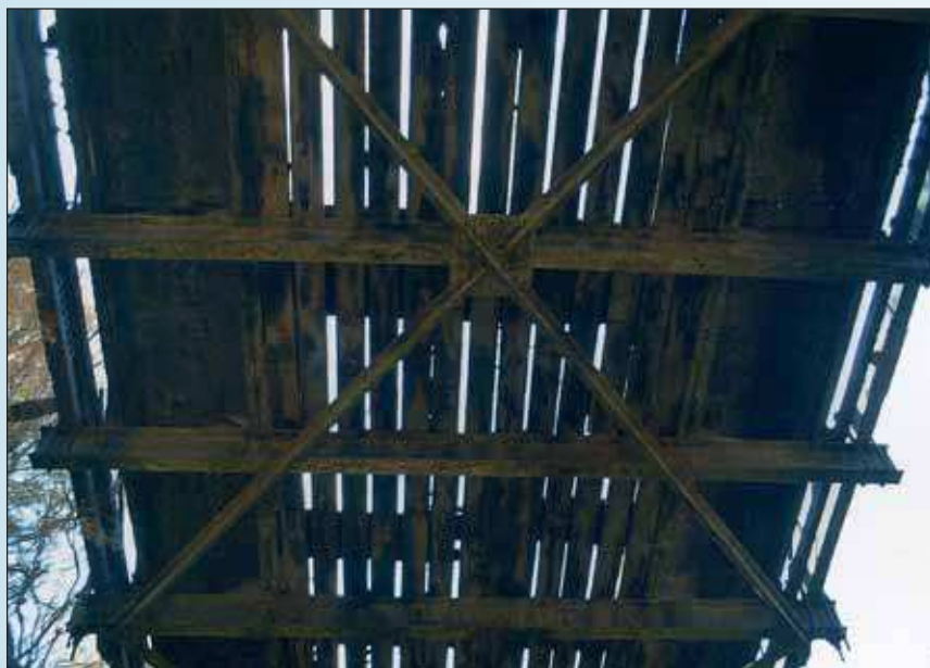
Рис. 5. Настил существующей проезжей части
