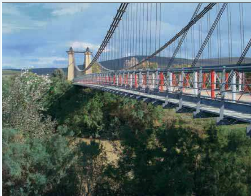
Рис. 16. Новый мост Чиани
