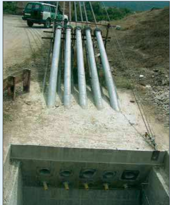
Рис. 10. Анкера новых главных несущих канатов, забетонированные в существующей анкерной камере
