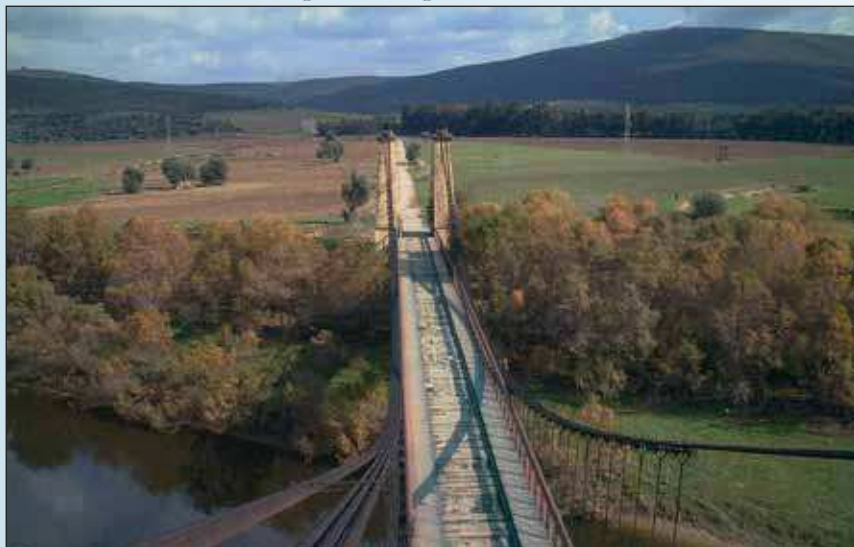
Рис. 1. Мост Чиани до начала ремонтных работ
